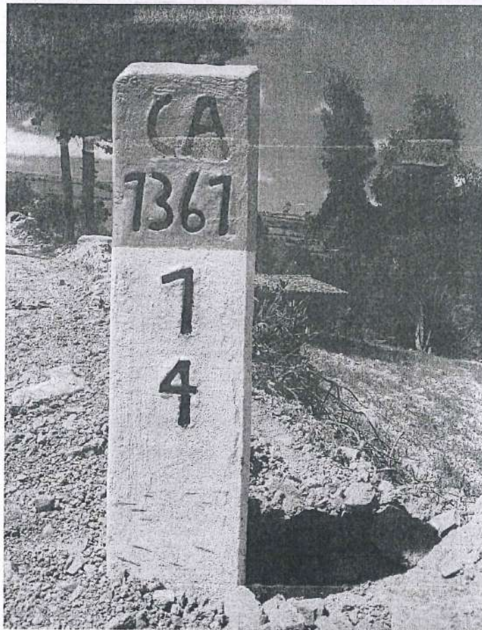
Fotografía 25. Instalación de hito kilométrico en KM 14+000.
