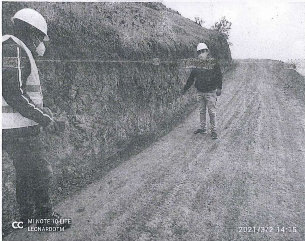
Fotografía 53. Verificación del cumplimiento de la partida de reconformación de cunetas.
