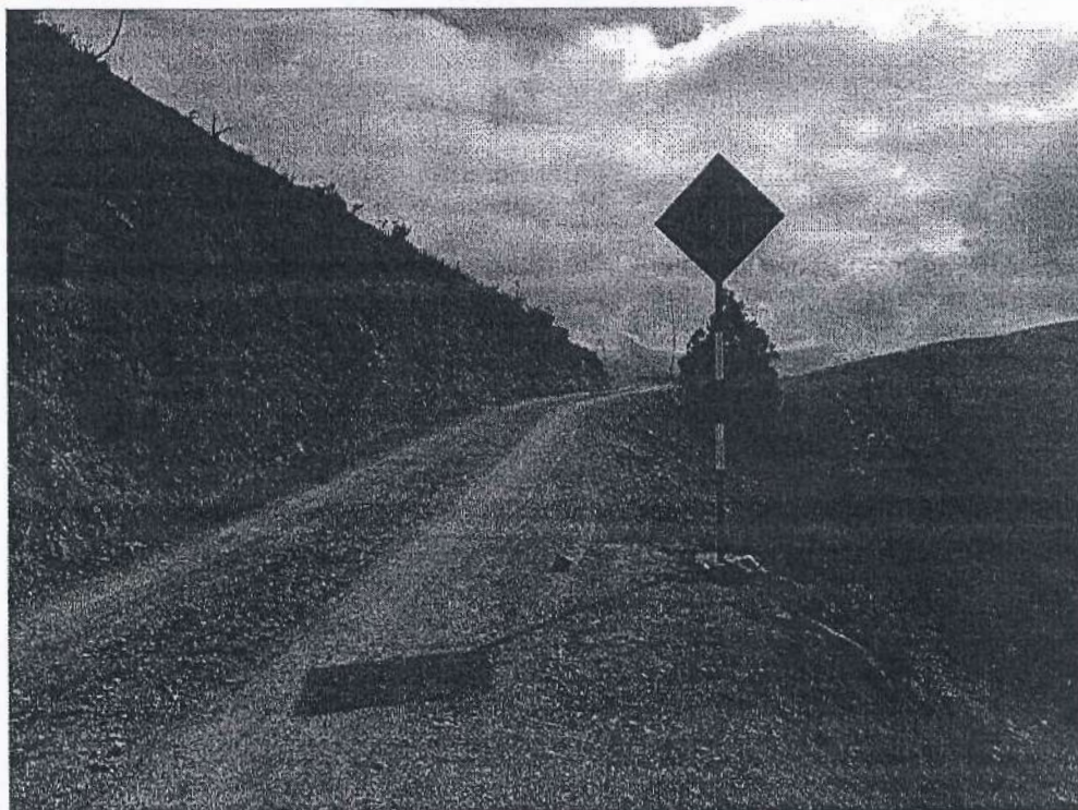
Fotografía 12. Instalación de Señales Preventivas
