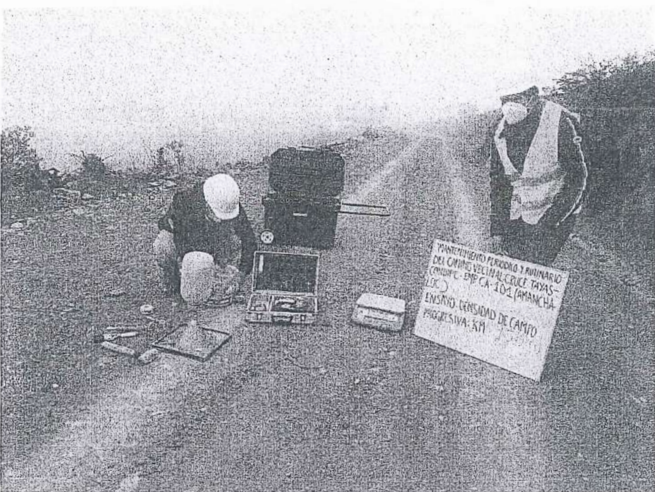
FOTOGRAFÍA N°19. Ensayo N°19 de Densidad de Suelo en Campo (Método del cono de arena) en la progresiva Km 15+240.
