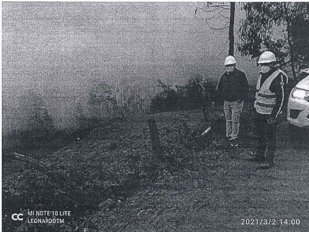
Fotografía 21. Verificación de los daños ocasionados a una señal reglamentaria por personas ajenas a la obra .
