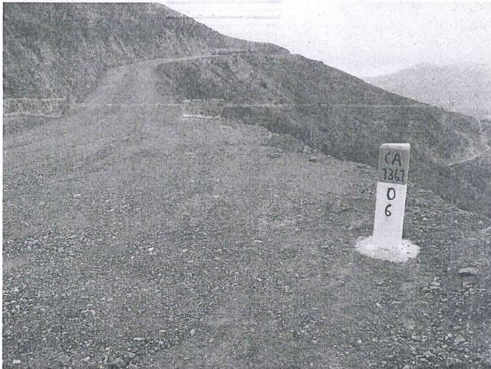
Fotografía 17. Instalación de hito kilométrico en KM 06+000.
