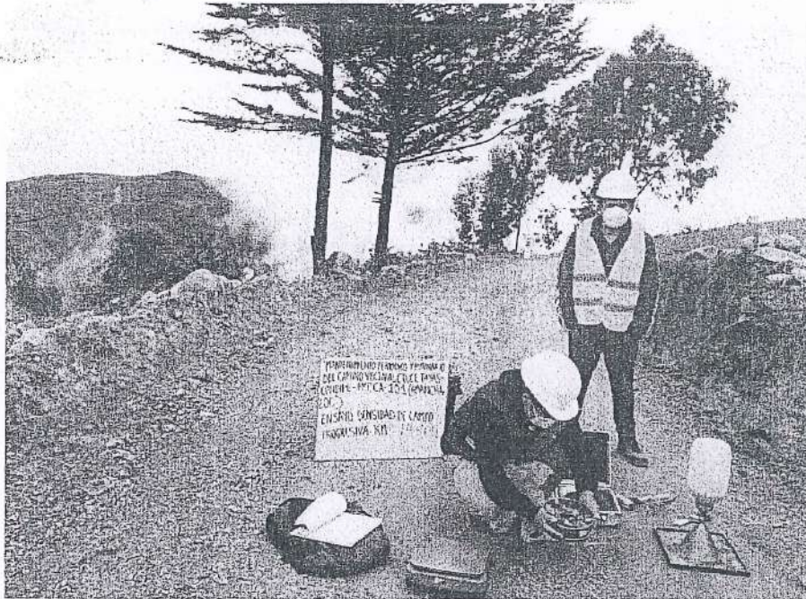
FOTOGRAFÍA N°14. Ensayo N°14 de Densidad de Suelo en Campo (Método del cono de arena) en la progresiva Km 14+000.
