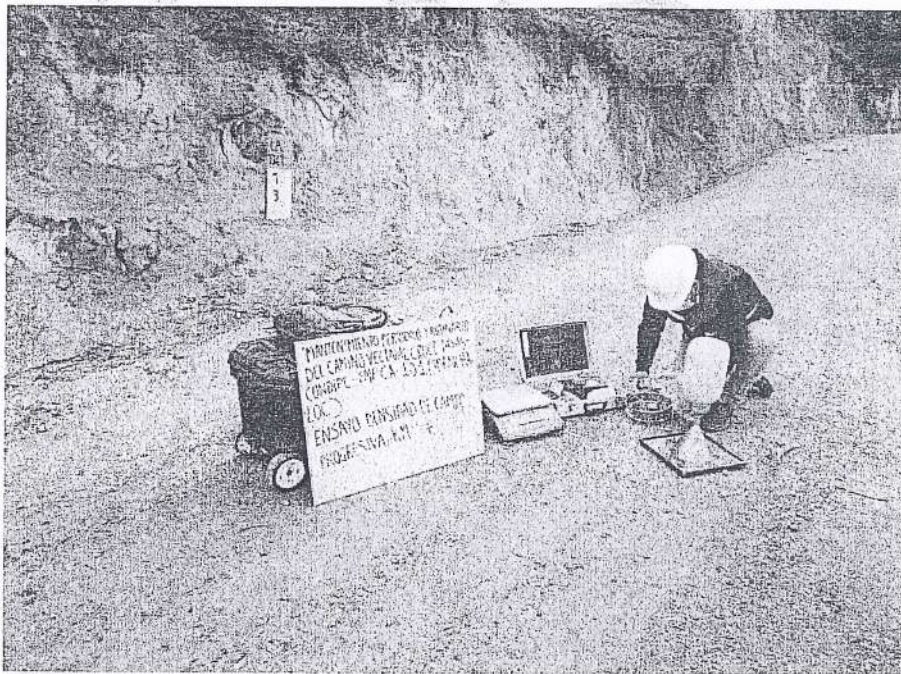
FOTOGRAFÍA N°10. Ensayo N°10 de Densidad de Suelo en Campo (Método del cono de arena) en la progresiva Km 13+000.
