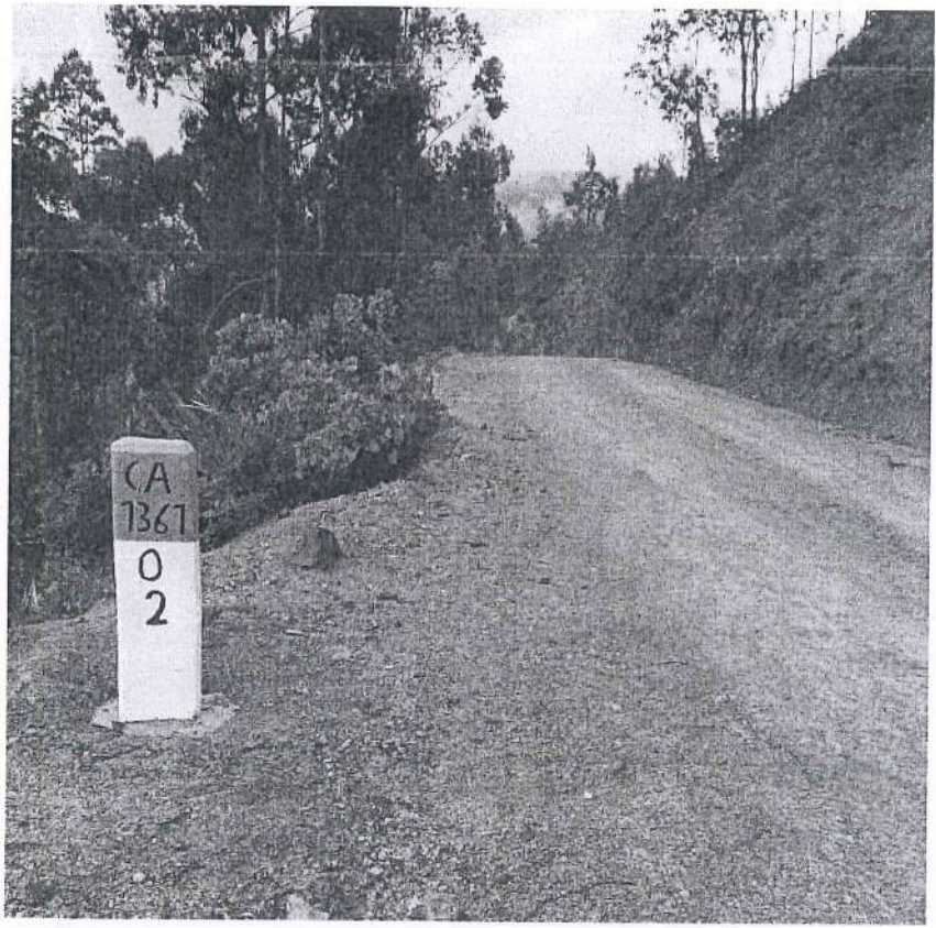
Fotografía 14. Instalación de hito kilométrico en KM 02+000.
