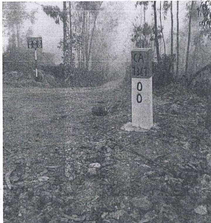
Fotografía 12. Instalación de hito kilométrico en KM 00+000.
