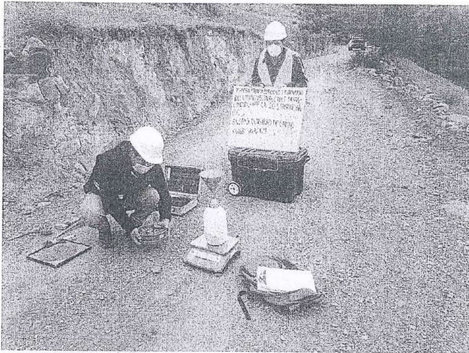
FOTOGRAFÍA N°15. Ensayo N°15 de Densidad de Suelo en Campo (Método del cono de arena) en la progresiva Km 14+250.
