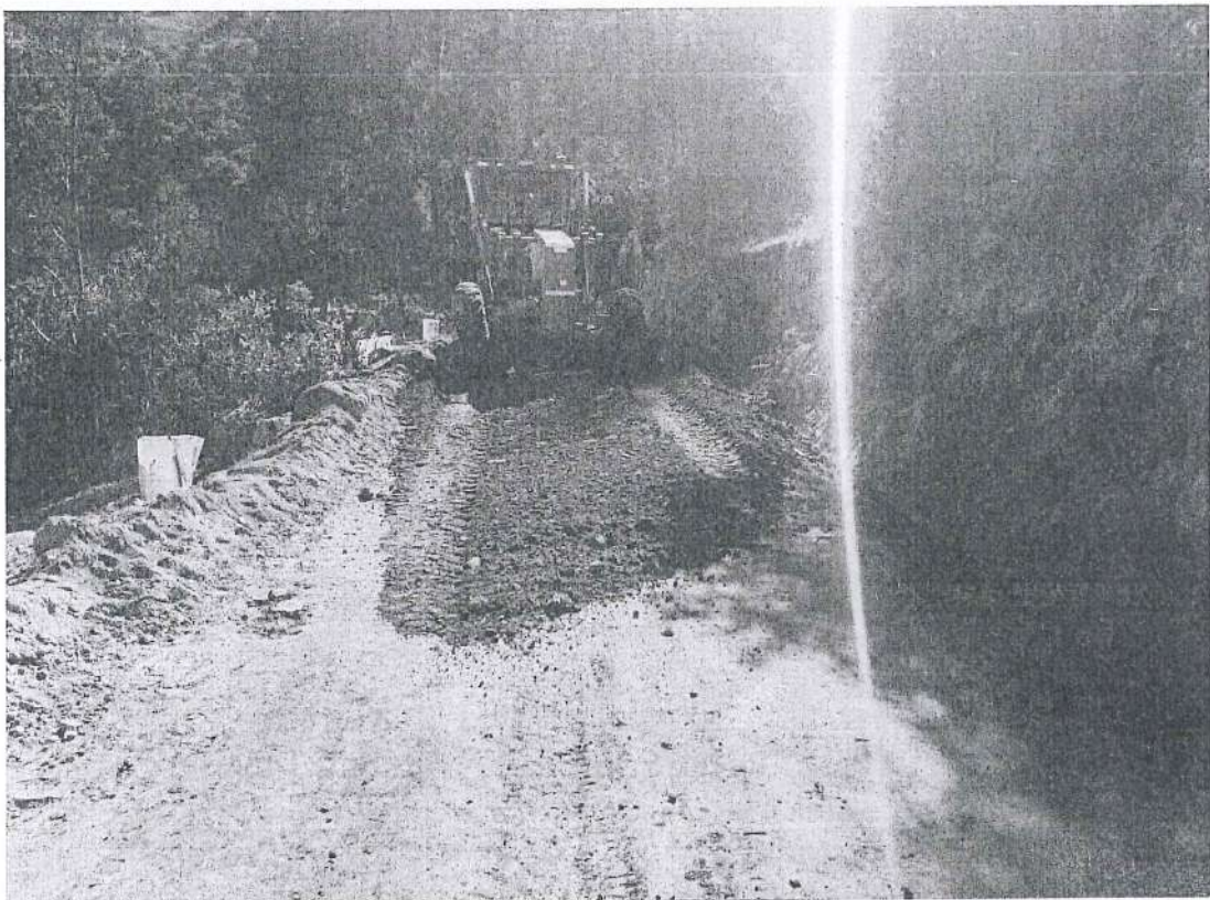
Fotografía 1. Rodillo realizando trabajos de compactación en la vía.
