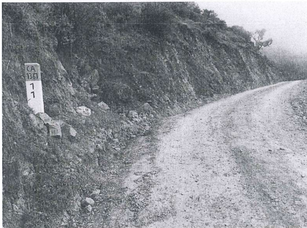
Fotografía 22. Instalación de hito kilométrico en KM 11+000.
