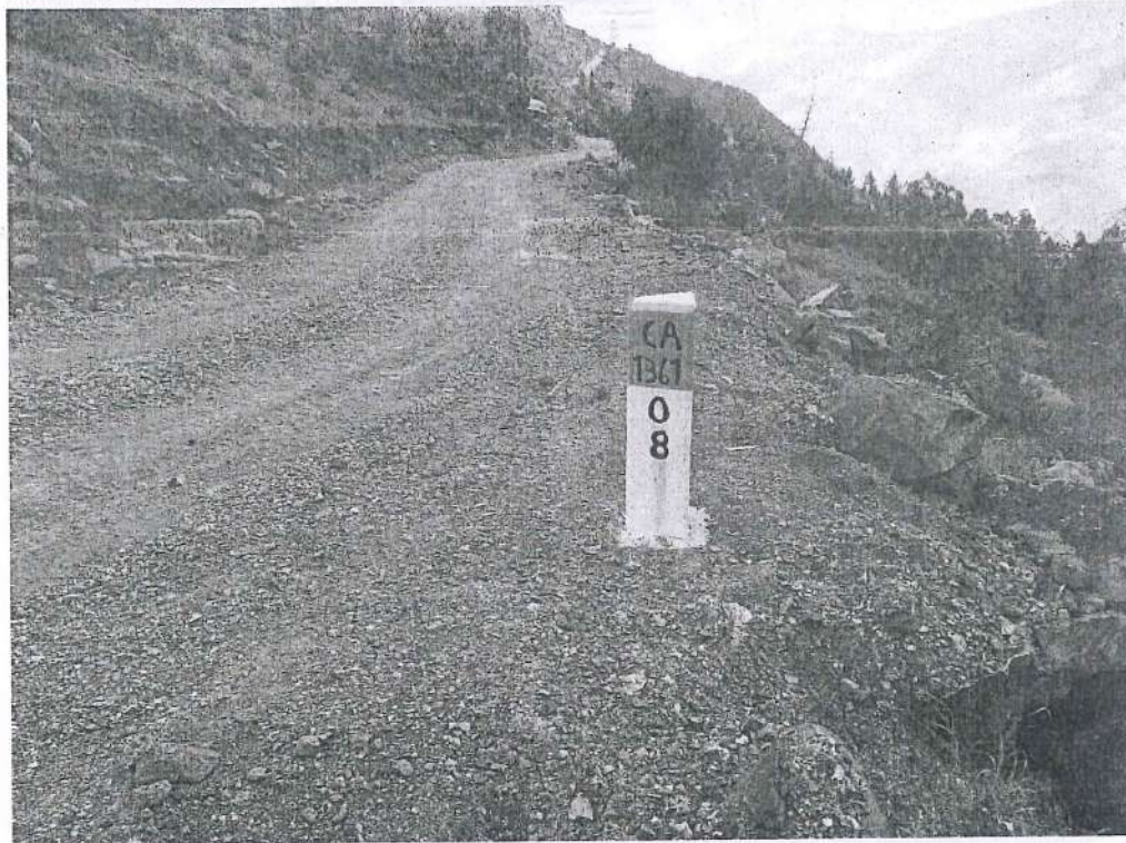
Fotografía 19. Instalación de hito kilométrico en KM 08+000.
