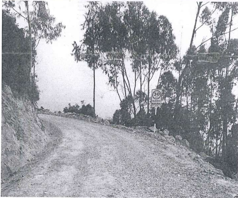
Fotografía 27. Instalación de Señales Reglamentarias.
