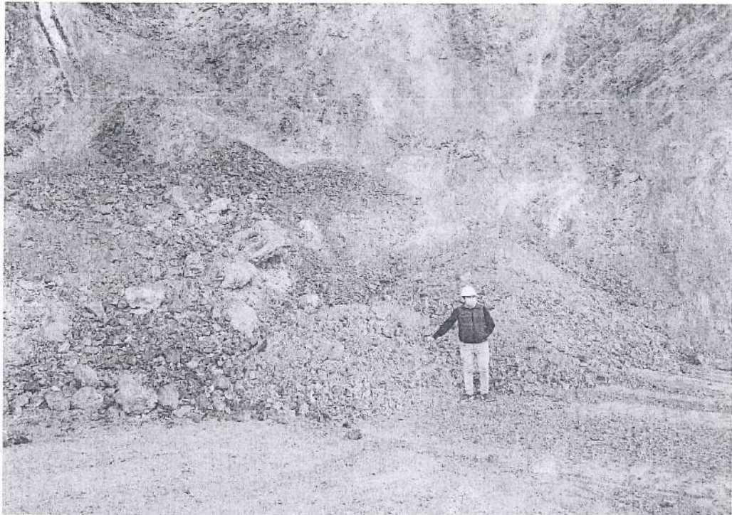
Fotografía 52. Verificación por parte del inspector que el material de cantera sea seleccionado.
