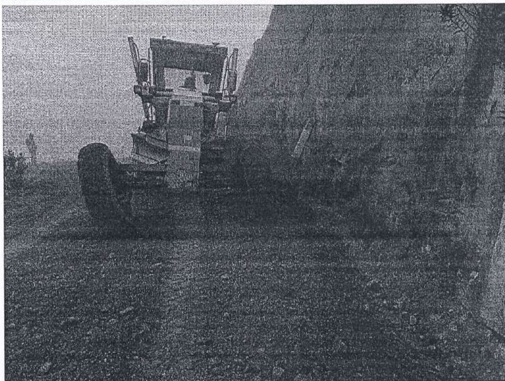
Fotografía 4. Motoniveladora realizando trabajos de Reconformación de cunetas.
