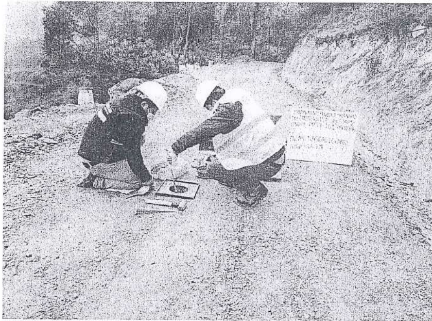
FOTOGRAFÍA N°9. Ensayo N°09 de Densidad de Suelo en Campo (Método del cono de arena) en la progresiva Km 12+750.
