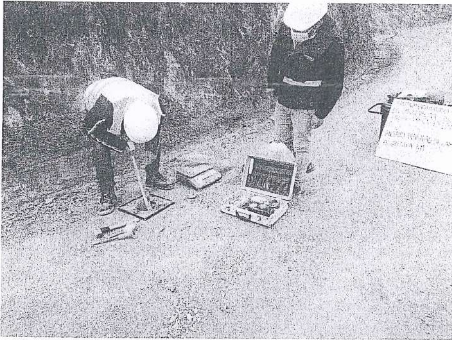
FOTOGRAFÍA N°17. Ensayo N°17 de Densidad de Suelo en Campo (Método del cono de arena) en la progresiva Km 14+750.
