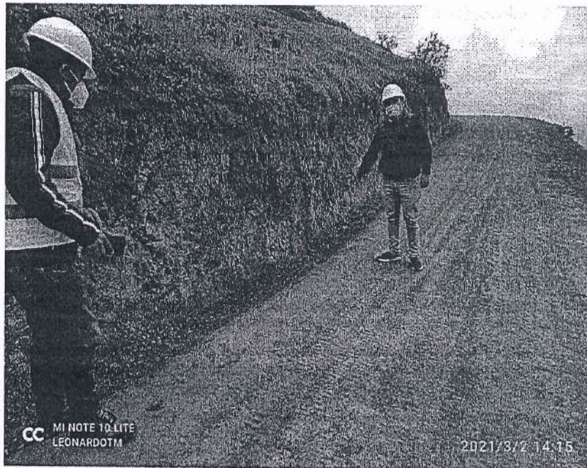
Fotografía 23. Verificación del cumplimiento de la partida de reconfirmación de cunetas.
