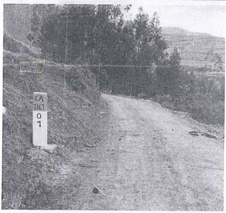
Fotografía 13. Instalación de hito kilométrico en KM 01+000.
