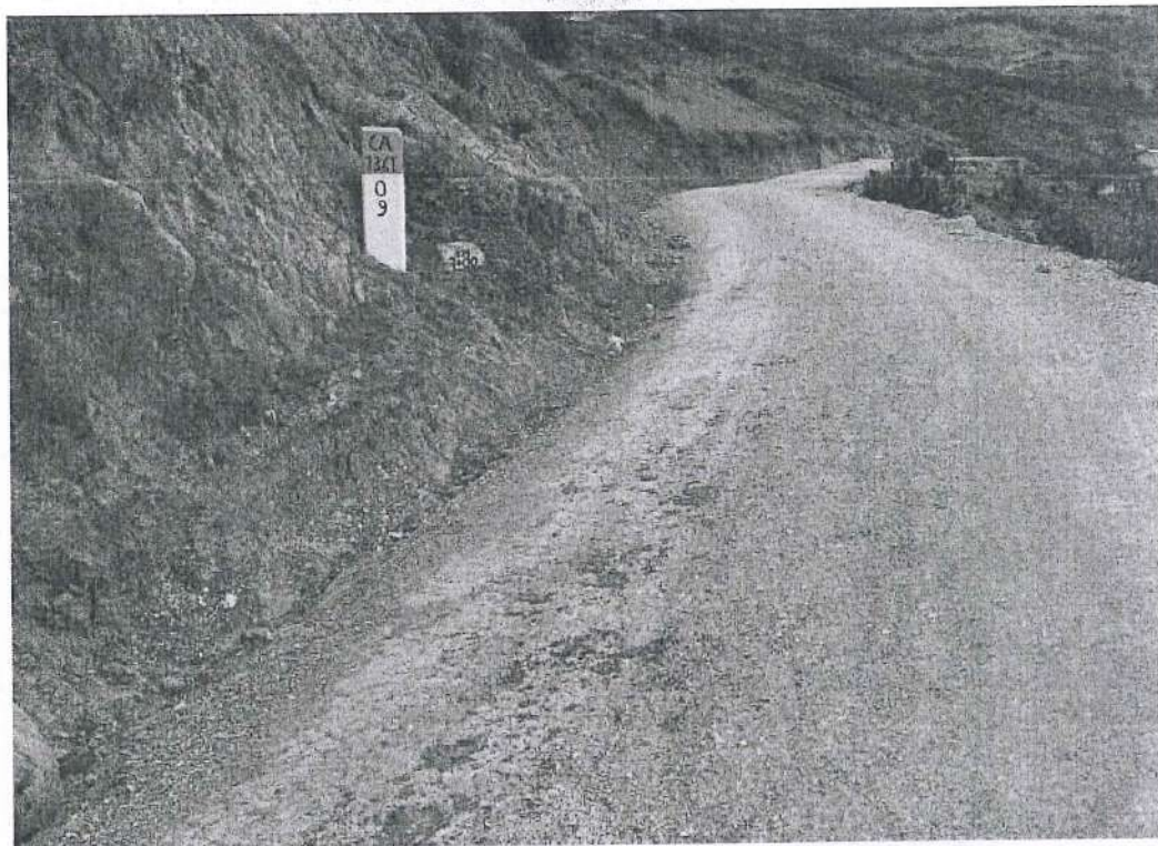
Fotografía 20. Instalación de hito kilométrico en KM 09+000.
