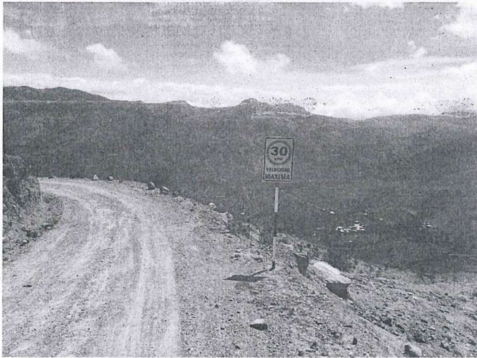
Fotografía 29. Instalación de Señales Reglamentarias.
