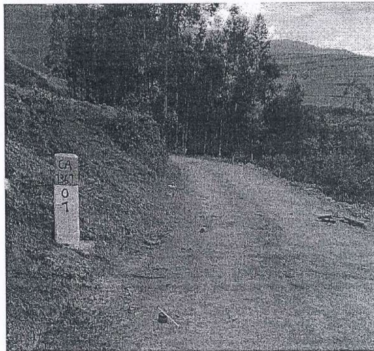
Fotografía 7. Instalación de hito kilométrico en KM 01+000.
