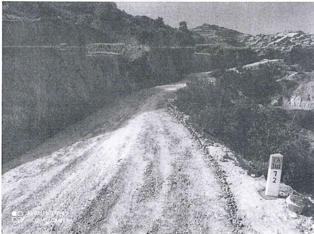
Fotografía 23. Instalación de hito kilométrico en KM 12+000.
