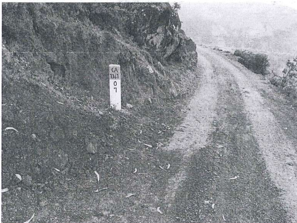
Fotografía 18. Instalación de hito kilométrico en KM 07+000.
