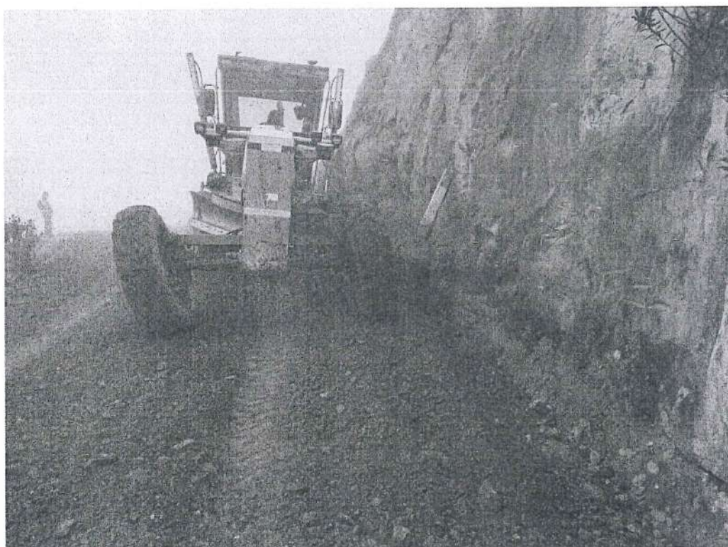
Fotografía 4. Motoniveladora realizando trabajos de Reconformación de cunetas.
