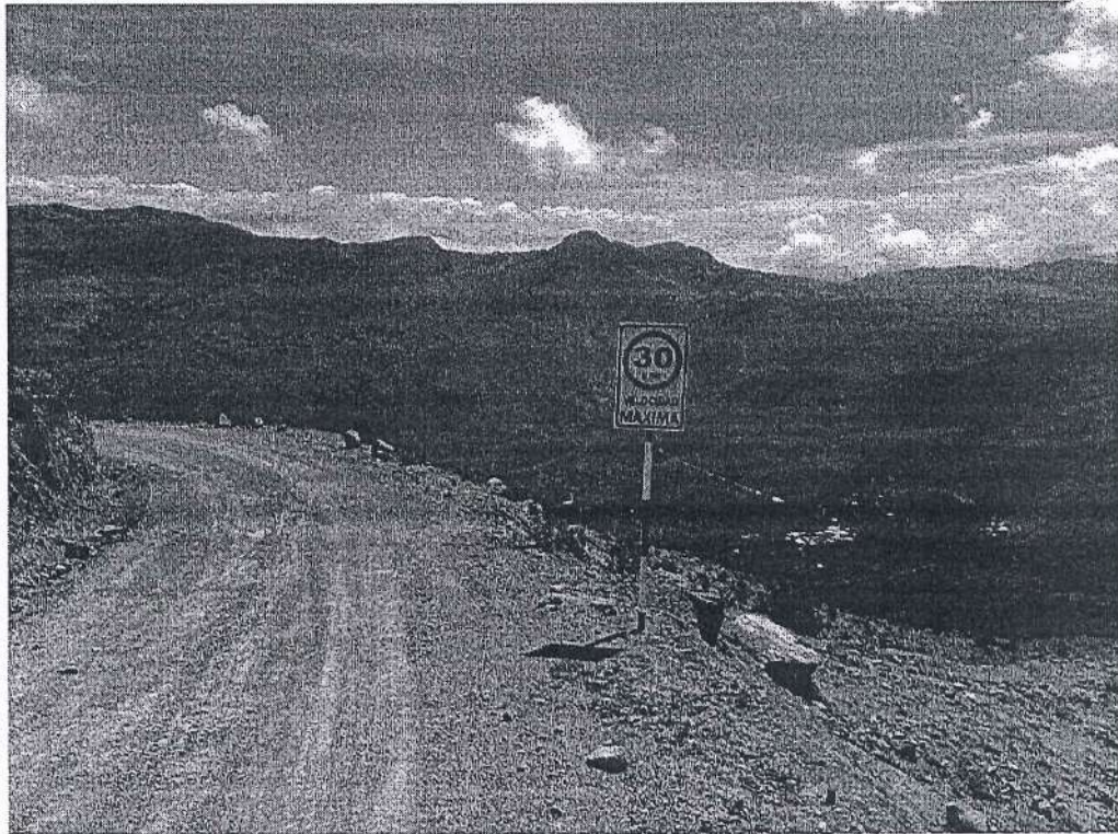
Fotografía 10. Instalación de Señales Reglamentarias.
