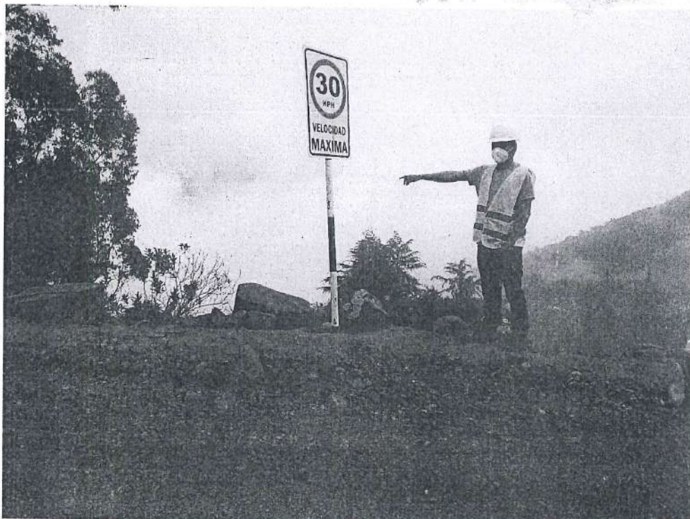
Fotografía 28. Instalación de Señales Reglamentarias.
