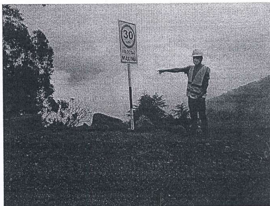
Fotografía 9. Instalación de Señales Reglamentarias.
