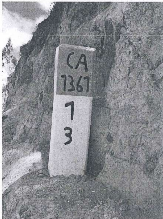
Fotografía 24. Instalación de hito kilométrico en KM 13+000.
