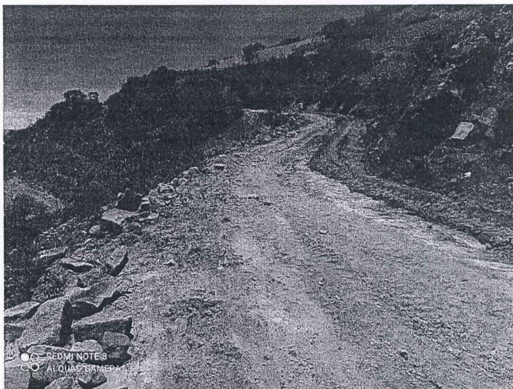
Fotografía 3. Motoniveladora realizando trabajos de Reconfiguración de cunetas.
