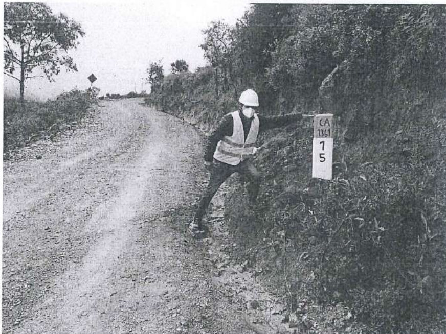
Fotografía 26. Instalación de hito kilométrico en KM 15+000.
