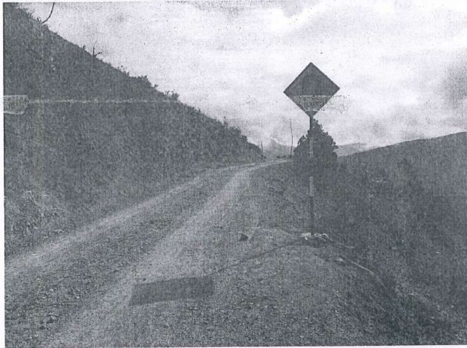
Fotografía 31. Instalación de Señales Preventivas
