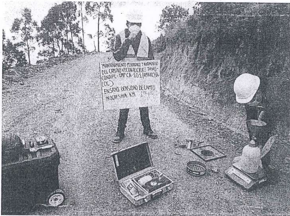
FOTOGRAFÍA N°16. Ensayo N°16 de Densidad de Suelo en Campo (Método del cono de arena) en la progresiva Km 14+500.
