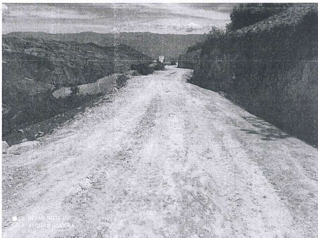
Fotografía 10. Vista panorámica de los trabajos realizados.
