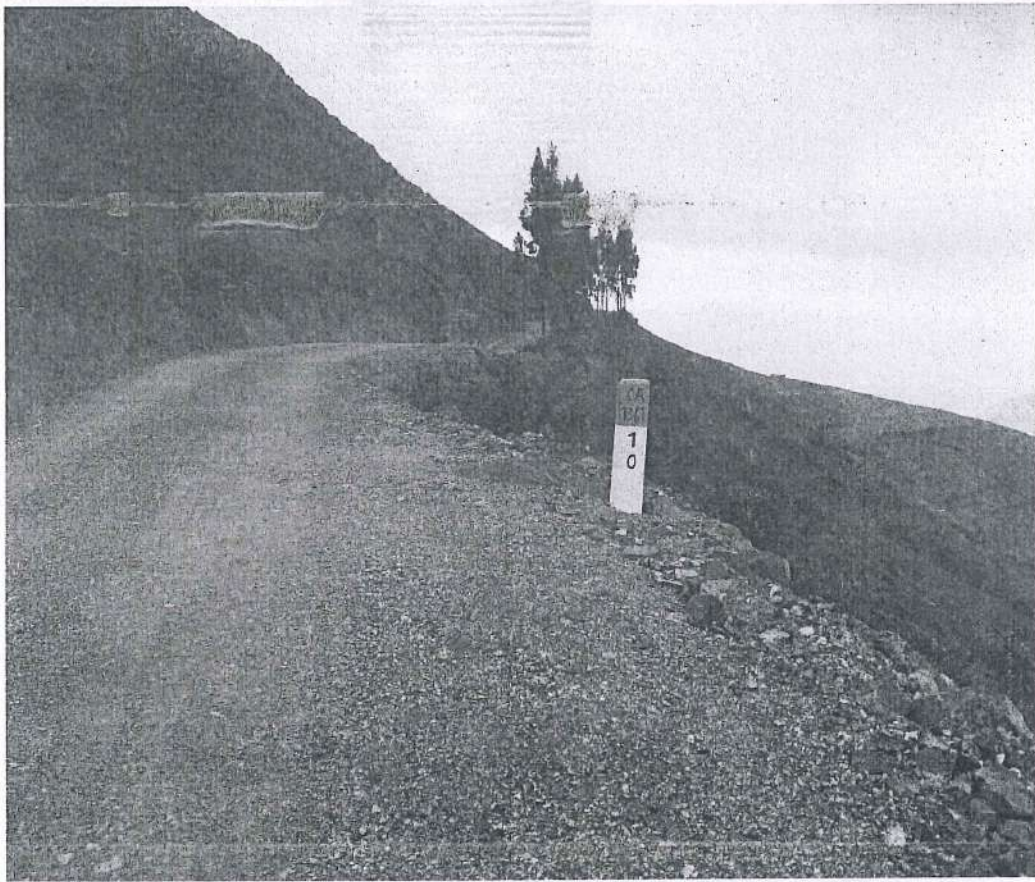
Fotografía 21. Instalación de hito kilométrico en KM 10+000.
