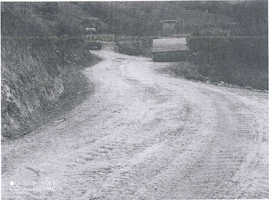
Fotografía 1. Rodillo realizando trabajos de compactación en la vía.
