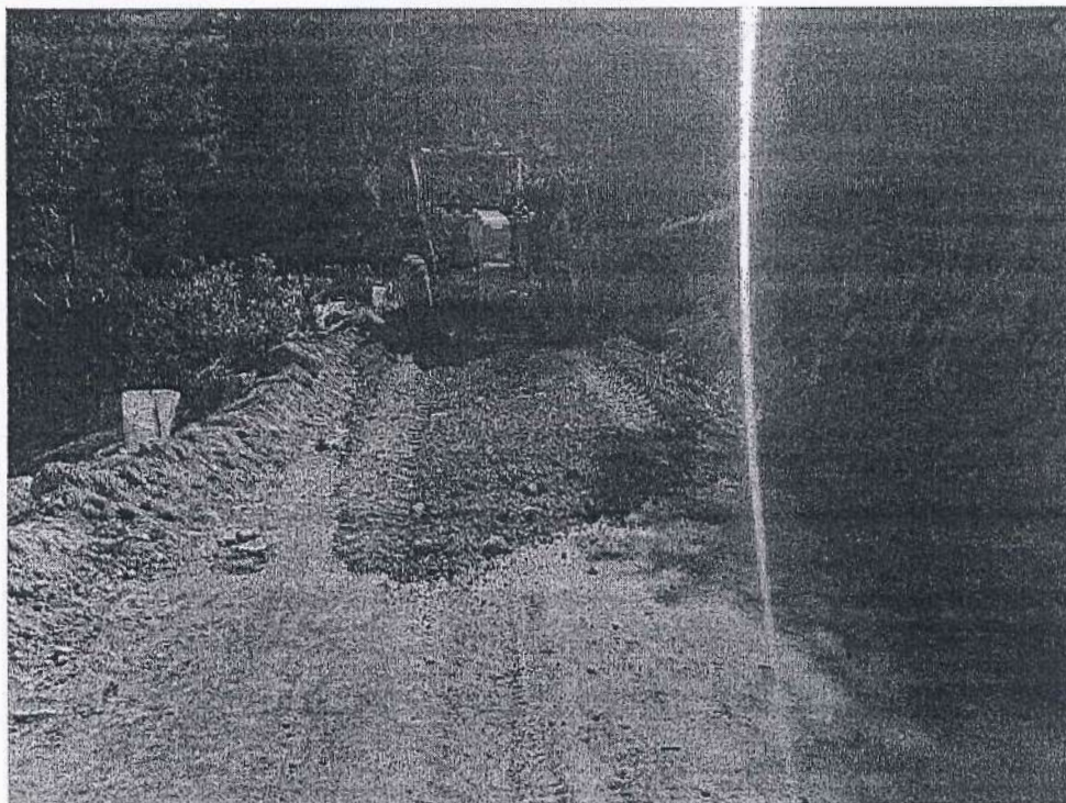
Fotografía 2. Motoniveladora realizando trabajos de extendido de material granular en la vía.
